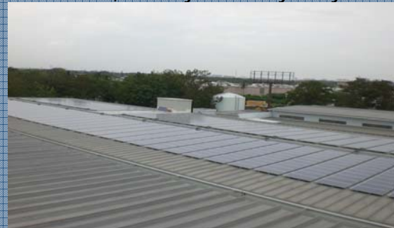
Paneles solares sobre techo de Mini Warehouse de Carolina
